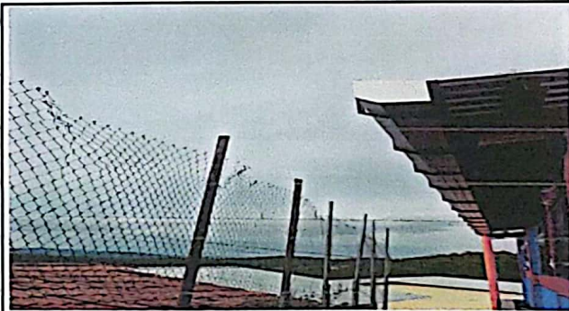
Foto 4: Vista del techo del establecimiento con canal instaladas.
