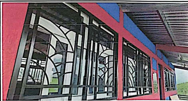
Foto 3: Vista de las ventanas con balcones instaladas.
